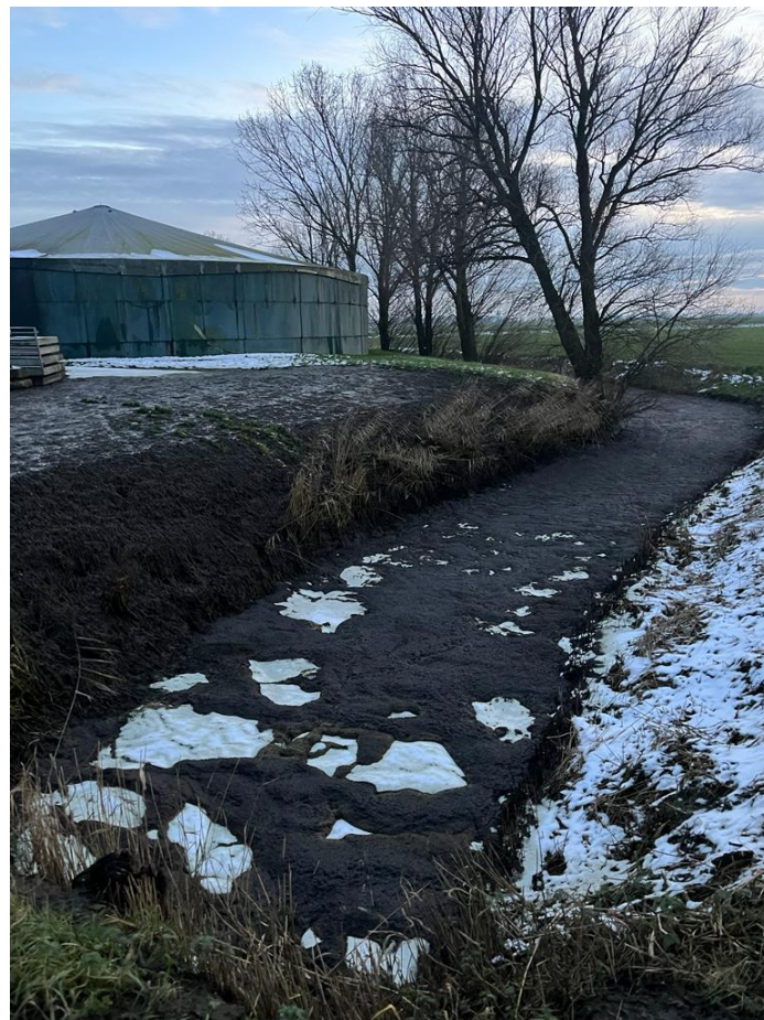
Indammen sloten – vervolgens uitzuigen (inclusief sliblaag)
