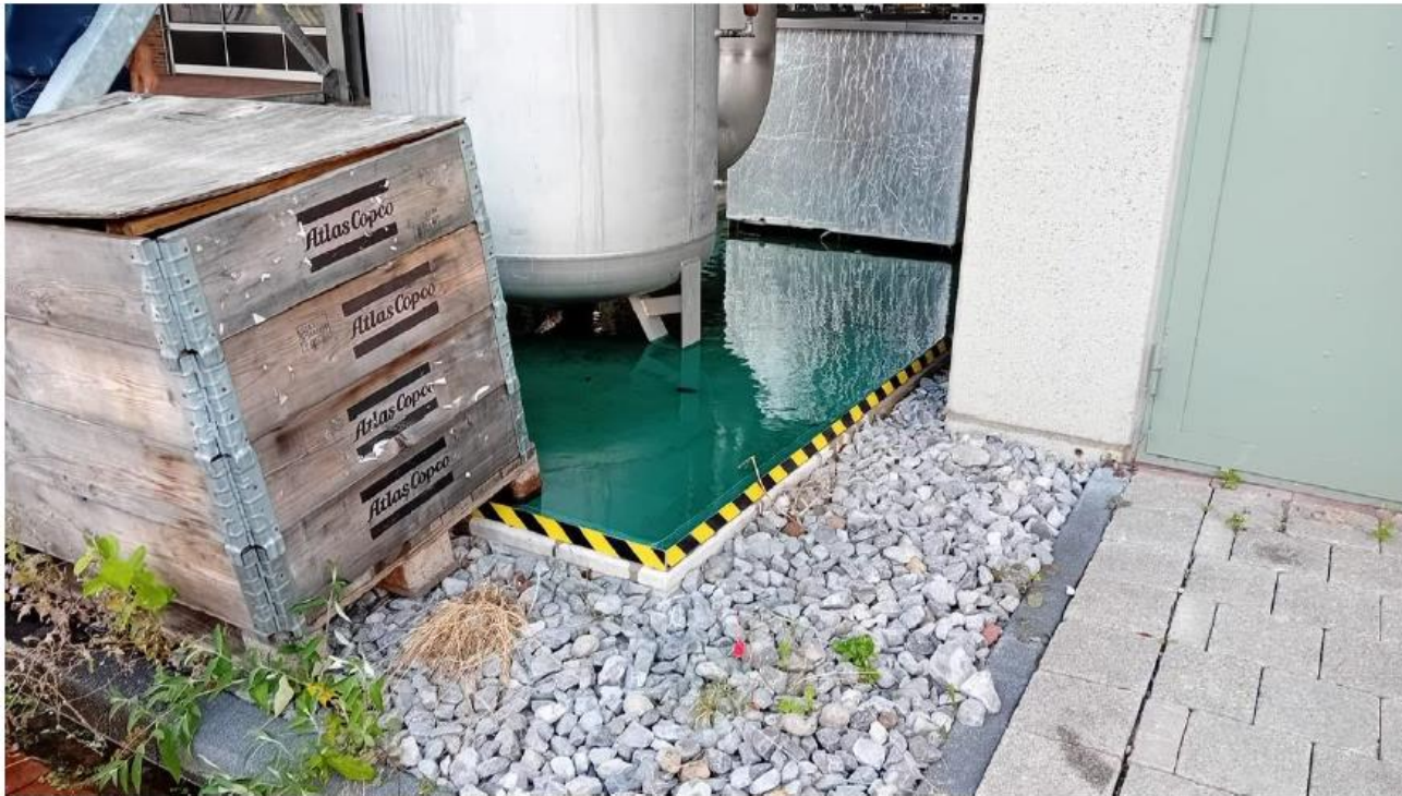
Opvangbak overstroomd naar de bodem en riool (foto rechts)
